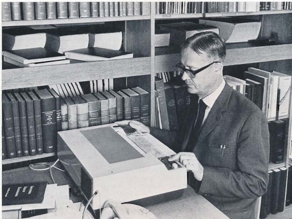
Hellfax-Transceiver HF 146, Bild 3.
